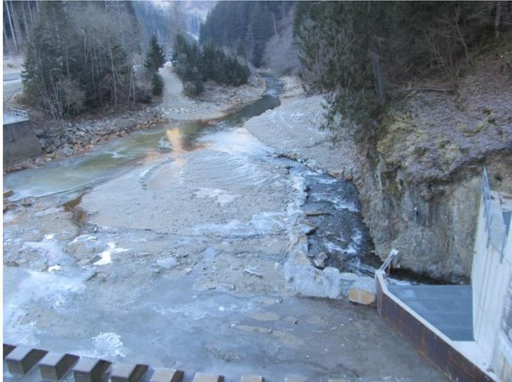
Abb. 10: Einstiegsbereich des Fischliftes bei KW Gößnitz an der Möll
