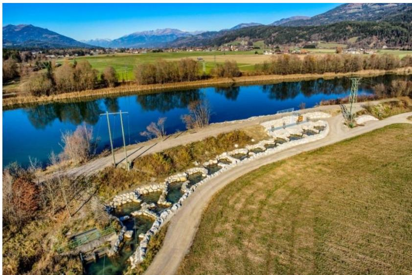
Abb. 9: Fischaufstiegshilfe Beim KW Kellerberg an der Drau (Foto:Verbund)
