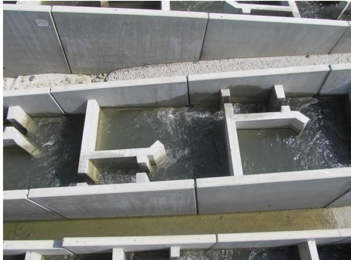
Abb. 11: Teil der Fischaufstiegshilfe (vertical slot) beim KW Grades an der Metnitz
