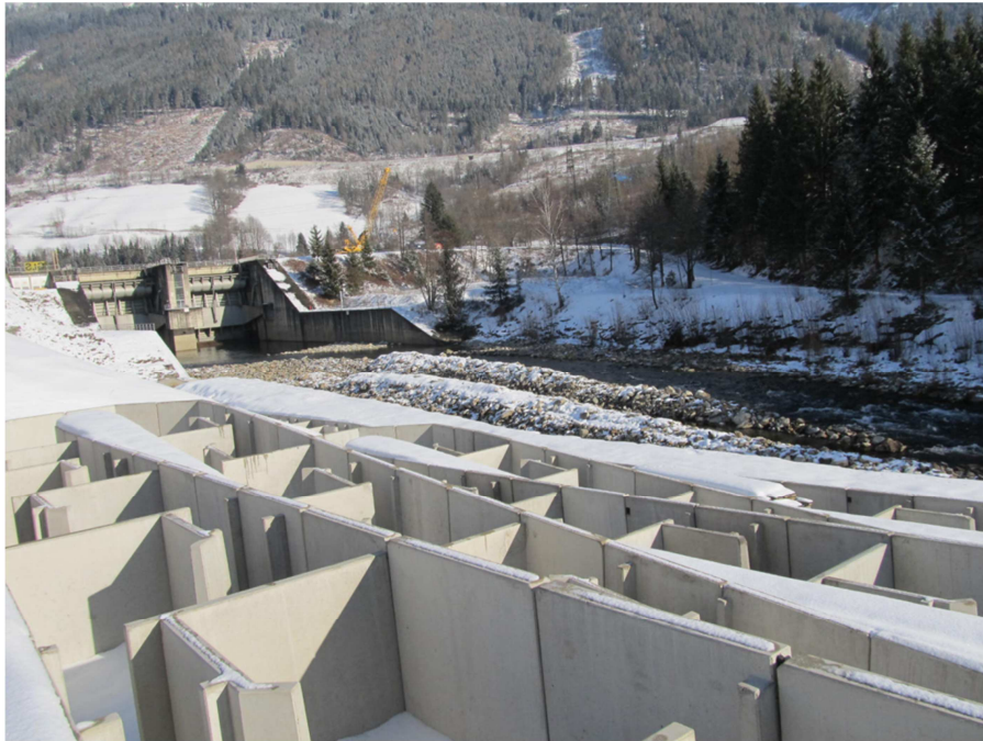
Abb. 3: Fischaufstiegshilfe beim KW Rosegg an der Drau
