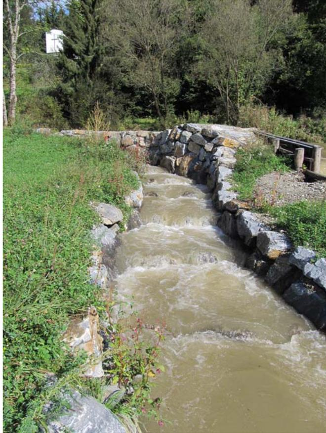
Abb. 4: Fischaufstiegshilfe beim KW Spitzing an der Gurk in Weitensfeld
