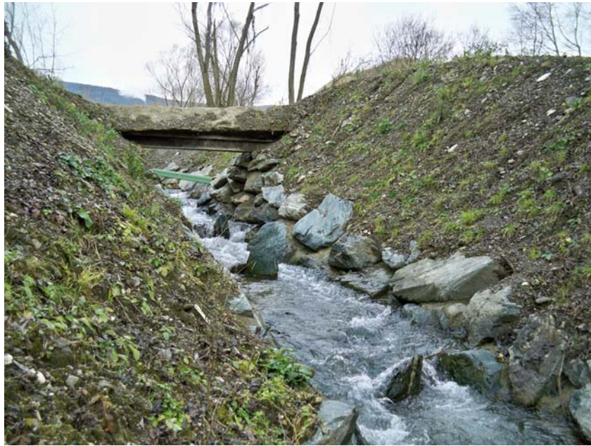
Abb.4: Fischaufstiegshilfe beim KW Tilly an der Gurk in Mölbling
