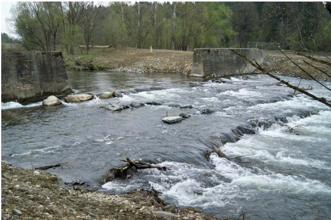
Abb.6. Lavant bei St. Paul: umgebaute Sohlstufe als aufgelöste Sohlrampe
