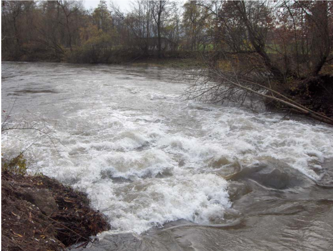
Abb.13: Mündung des Unterwasserkanals des KW Rain in die Gurk; Absturzbauwerk
