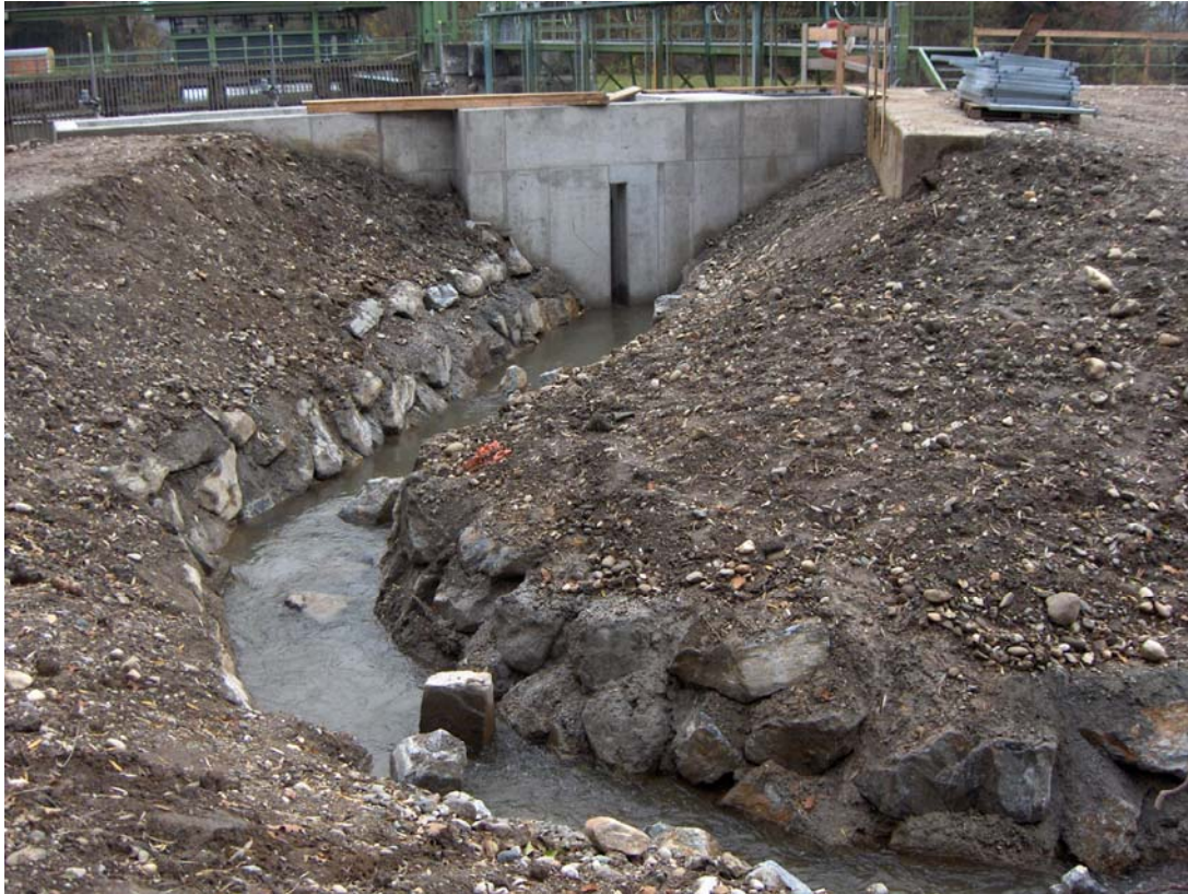
Abb.11: Dotationsbauwerk bei der Fischaufstiegshilfe KW Rain
