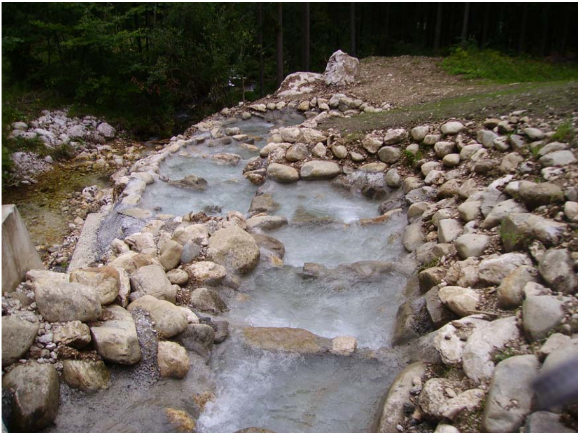
Abb. 9: Fischaufstiegshilfe beim KW Kraut (Feistritz; Foto: T. Friedl)
