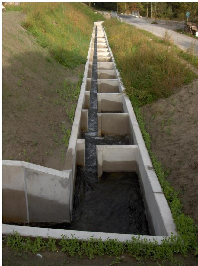
Abb. 9: Fischaufstiegshilfe (FAH) beim Kraftwerk Villach (Schlitzpass)
