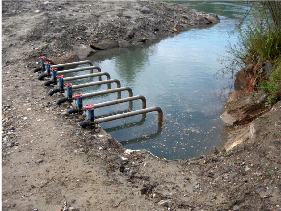
Abb.10: Dotationsbauwerk beim Einstieg der FAH zur Erhöhung der Lockströmung
