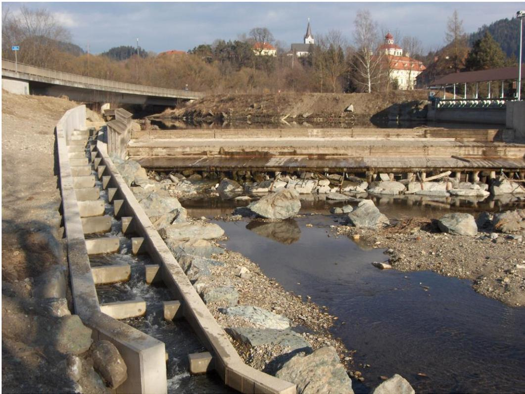
Abb. 11: Fischaufstiegshilfe an der Gurk in Pöckstein (Schlitzpass)
