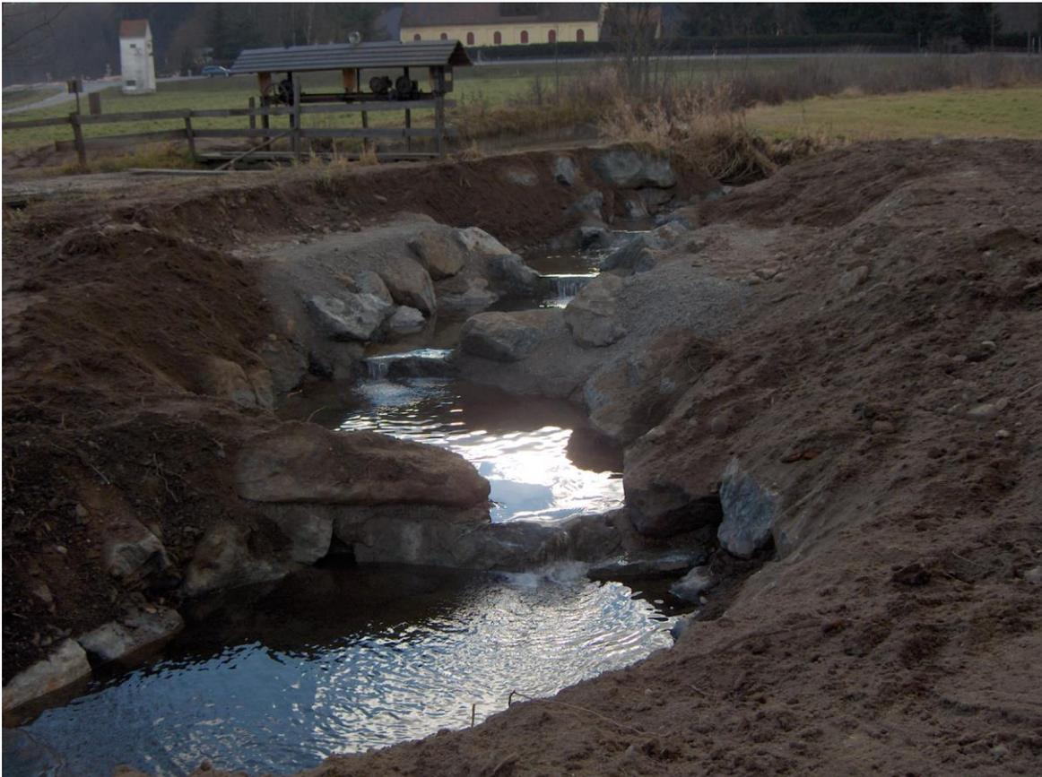
Abb.4: Fischaufstiegshilfe beim KW Rieger in Wiesenau
