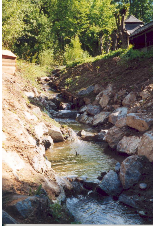
Abb.4: Fischaufstigshilfe an der Metnitz in Pöckstein
