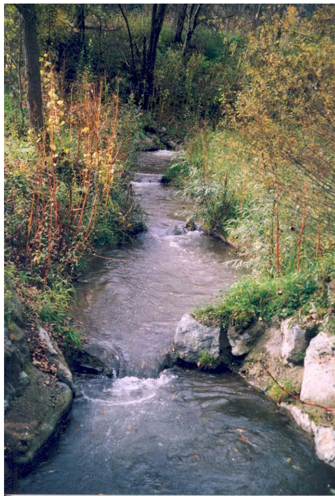
Abb. 6: Fischaufstiegshilfe an der Gurk in Pölling
