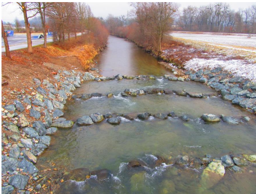
Abb. 5: Zu einer Sohlrampe umgebauter Sohlabsturz an der Lavant beim Sportplatz St. Andrä
