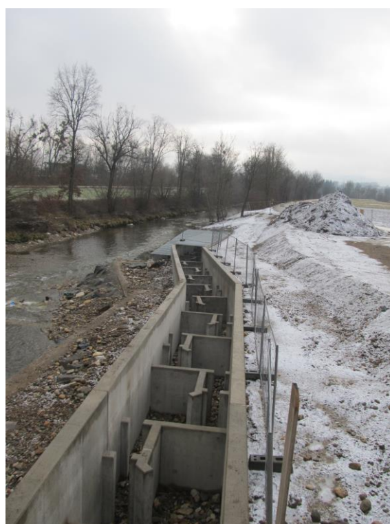
Abb. 6: „Vertical slot“- Fischpass beim Fischeringer Wehr (in Bau)
