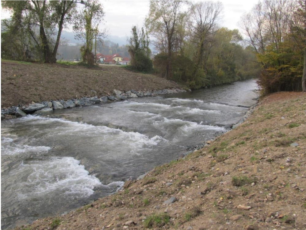
Abb.5: Zu einer Sohlrampe umgebaute Sohlstufe an der Lavant bei Blaiken (St. Andrä)
