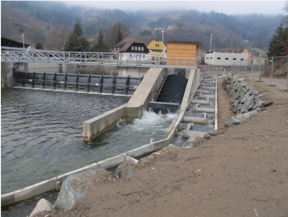
Abb. 4: Technische Fischaufstiegshilfe und Restwasserschnecke an der Lavant beim KW Wallerhof in Wolfsberg
