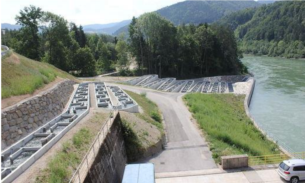
Abb. 6: Fischaufstiegshilfe beim KW Schwabeck an der Drau (Foto: Verbund)
